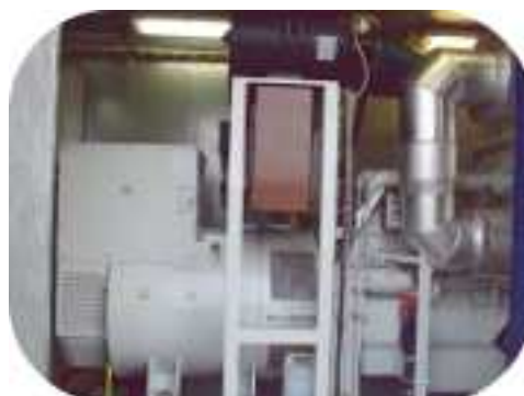
Particolare dell'alternatore e del motore endotermico a ciclo Otto
